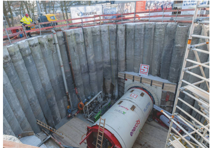
Julia Naber vom Enercity-Fernwärmevertrieb tauft die Tunnelbohrmaschine. Foto: Tim Schaarschmidt/Enercity
